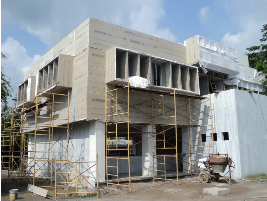
Construcción de Módulo de Aulas y Sanitarios.- Fac. Ciencias Biológicas y Agropecuarias
