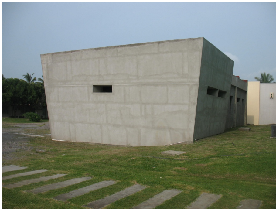
Construcción de Lab. de Neurociencias.- Facultad de Psicología
