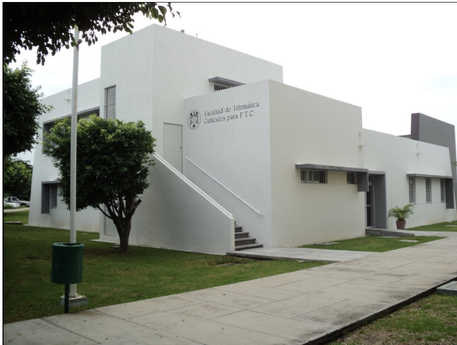
Construcción de Cubículos.- Facultad de Telemática
