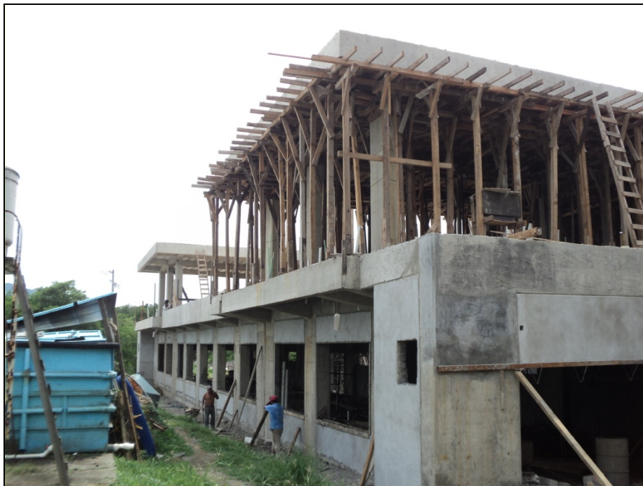
Construcción de Laboratorio de Manejo Integral Costero.- Fac. de Ciencias Marinas
