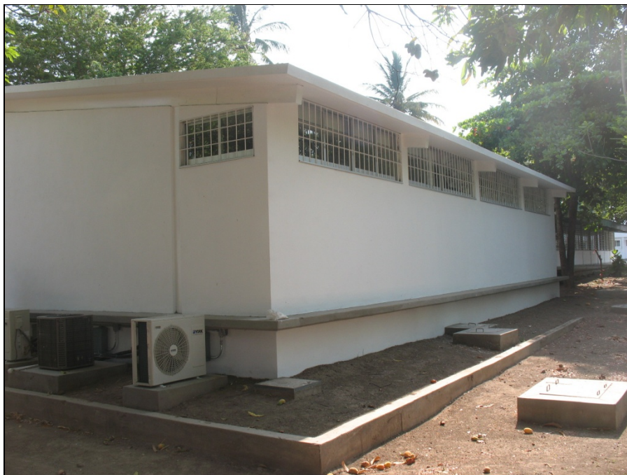
Construcción de Lab. de Habilidades.- Facultad de Ciencias de la Educación
