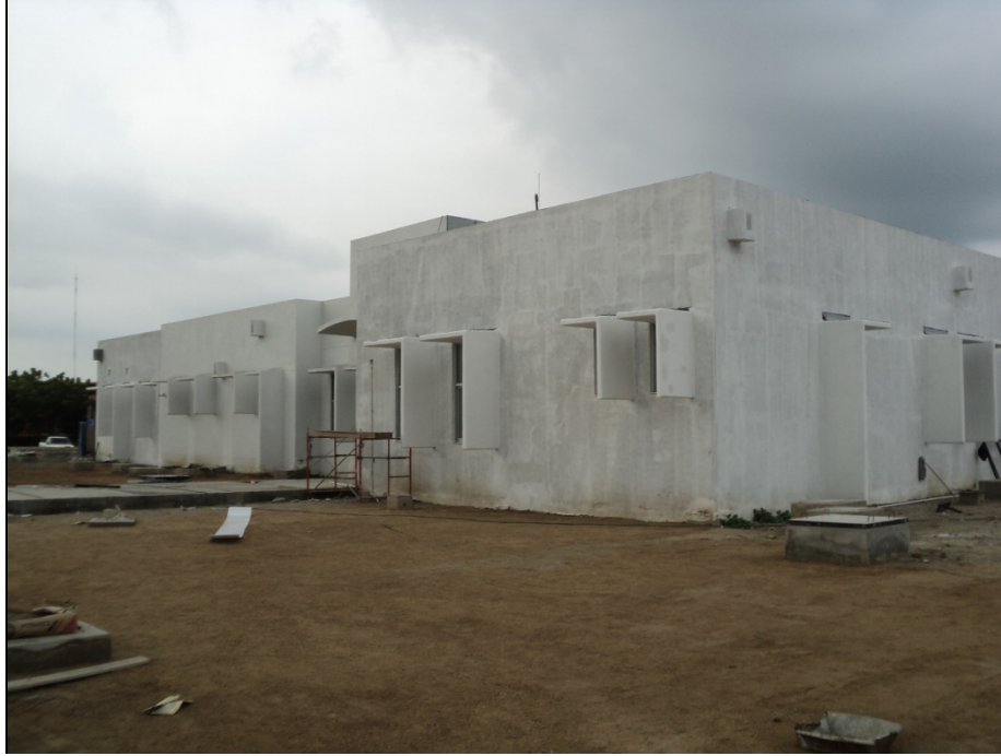
Construcción de Talleres de Gastronomía.- Escuela de Comercio Exterior
