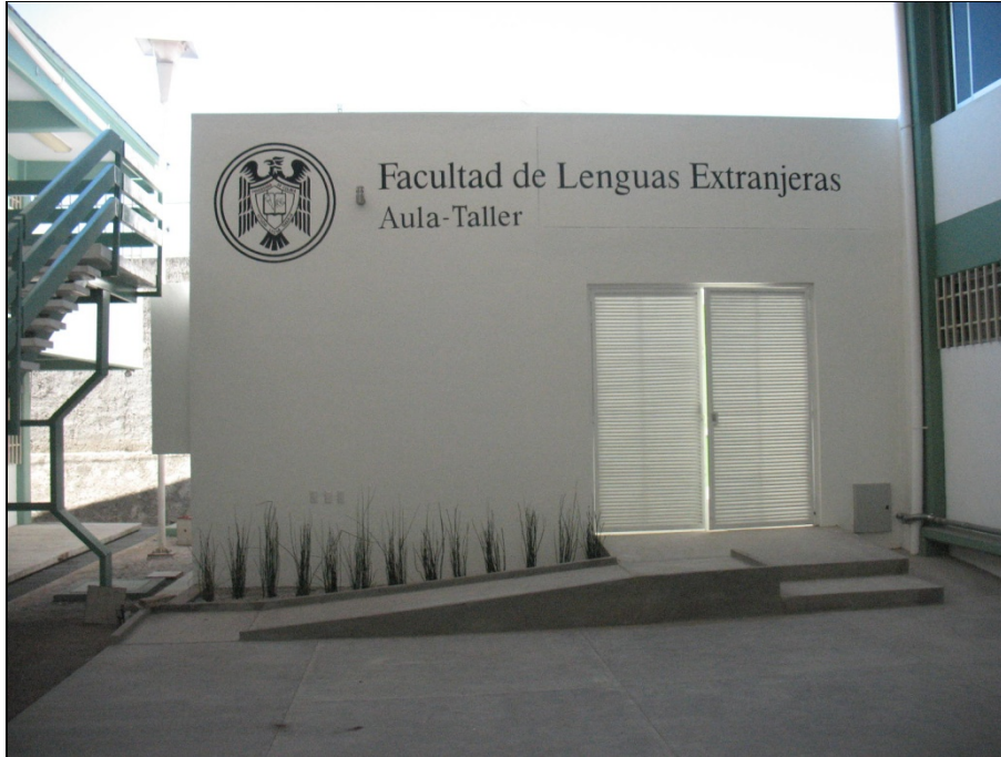
Construcción de Aula – Taller.- Facultad de Lenguas Extranjeras
