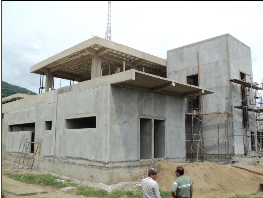
Construcción de Laboratorio de Oceanología Regional.- Facultad de Ciencias Marinas
