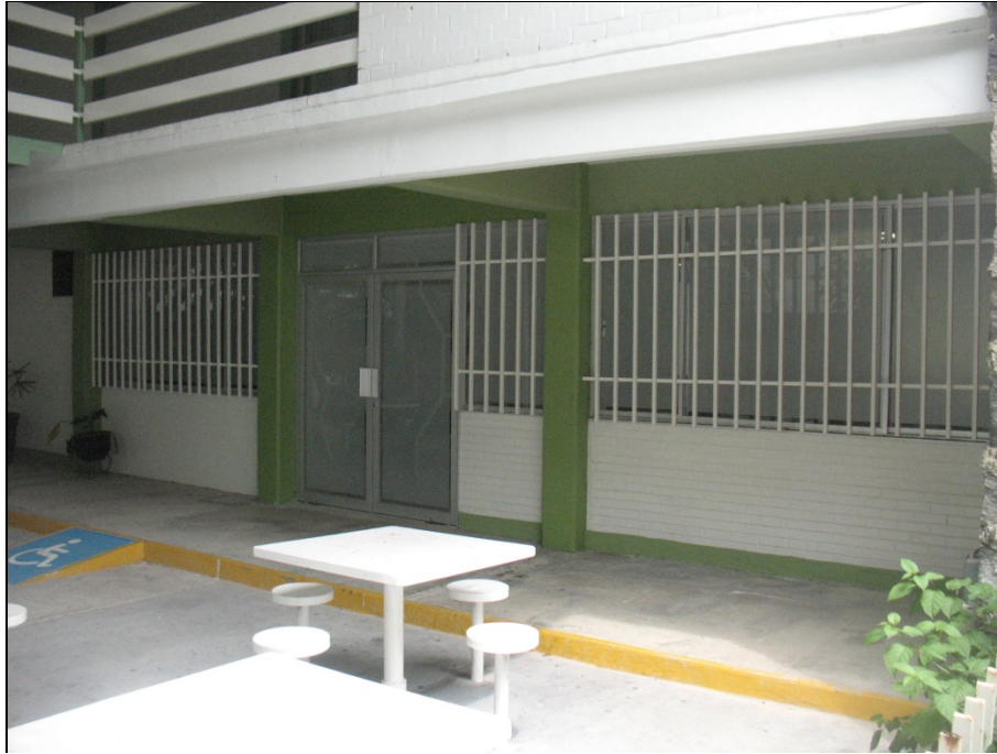
Adecuación de Cubículos y Sala de Juntas.- Escuela de Mercadotecnia
