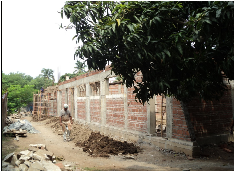
Construcción de Centro de Cómputo, Biblioteca y Sanitarios + Obra Exterior.- Bach. Tec. No. 14, El Colomo
