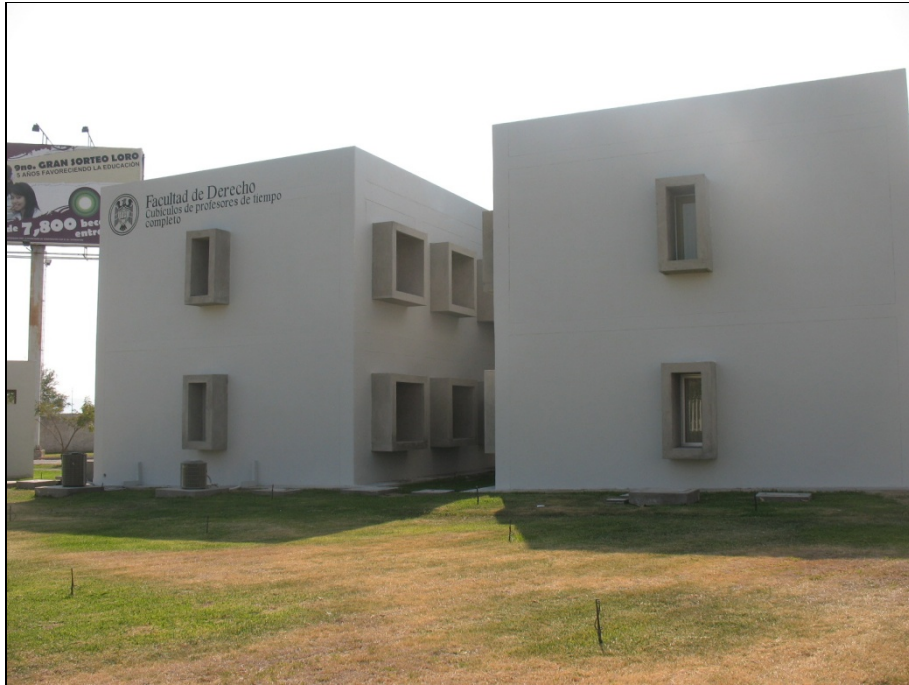
Construcción de Cubículos y Sala de Juicios Orales.- Facultad de Derecho
