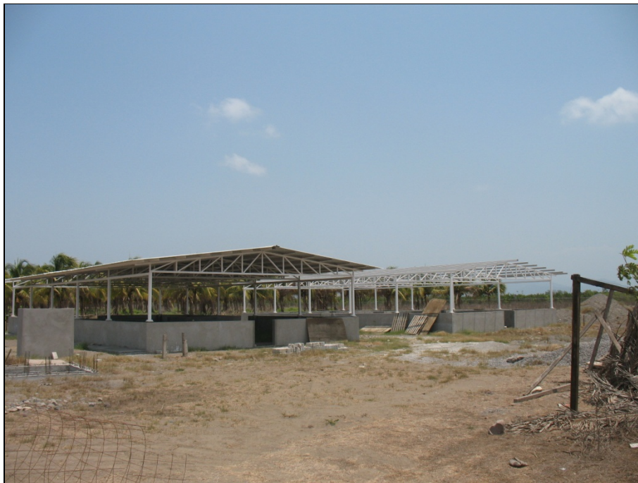
Construcción de Módulo Taller Porcícola.- Fac. de Medicina Veterinaria y Zootecnia
