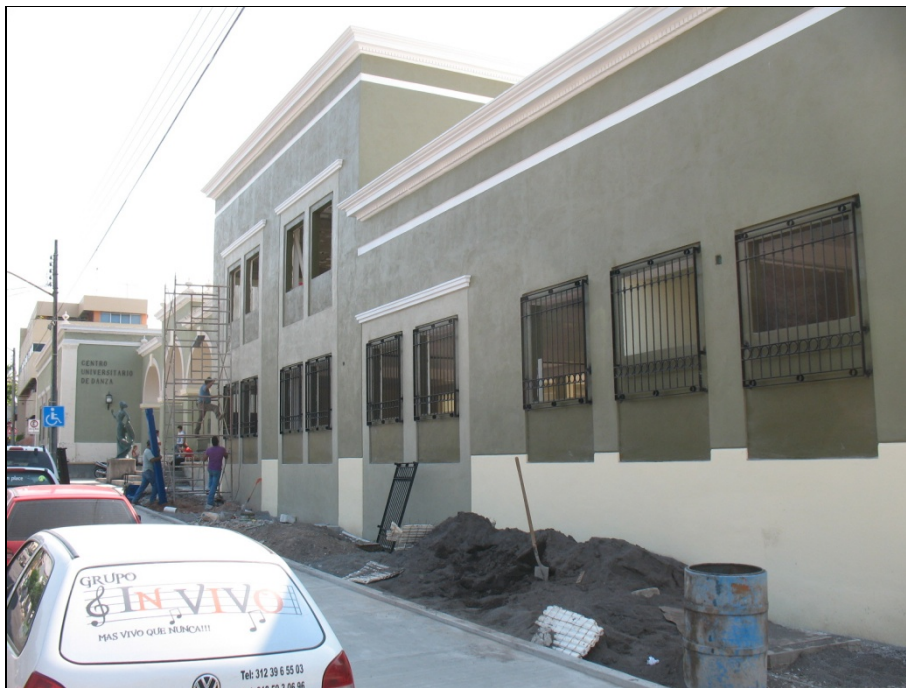
Construcción de Aulas y Cubículos.- I.U.B.A. Escuela de Danza
