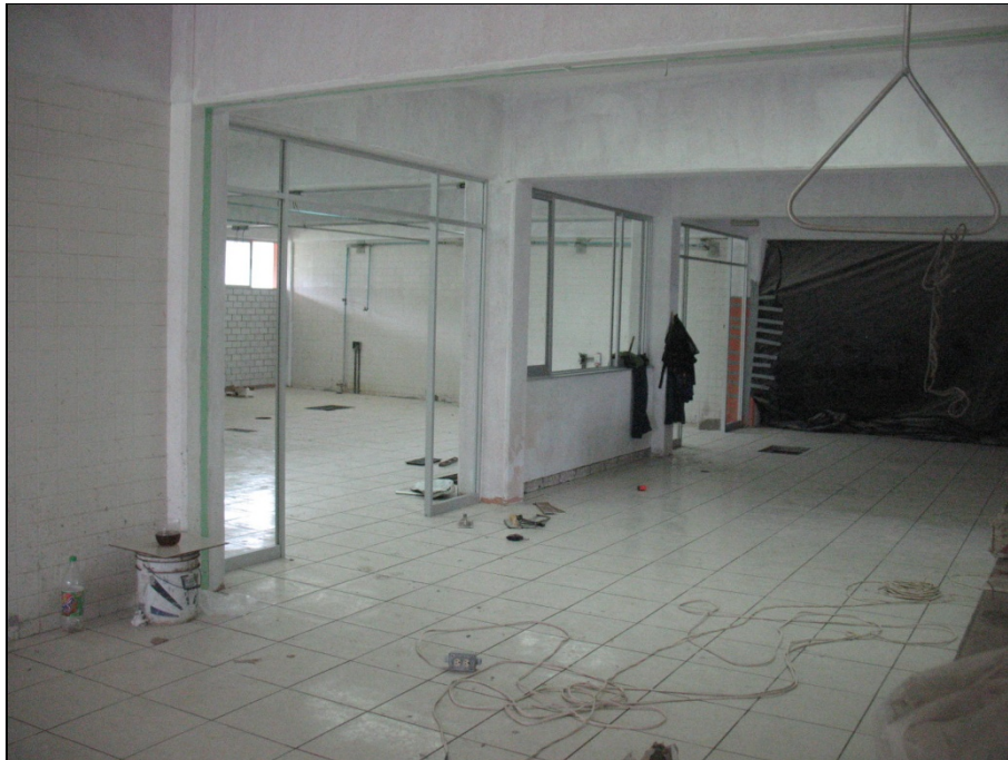
Adecuación de Laboratorio de Alimentos.- Facultad de Ciencias Químicas
