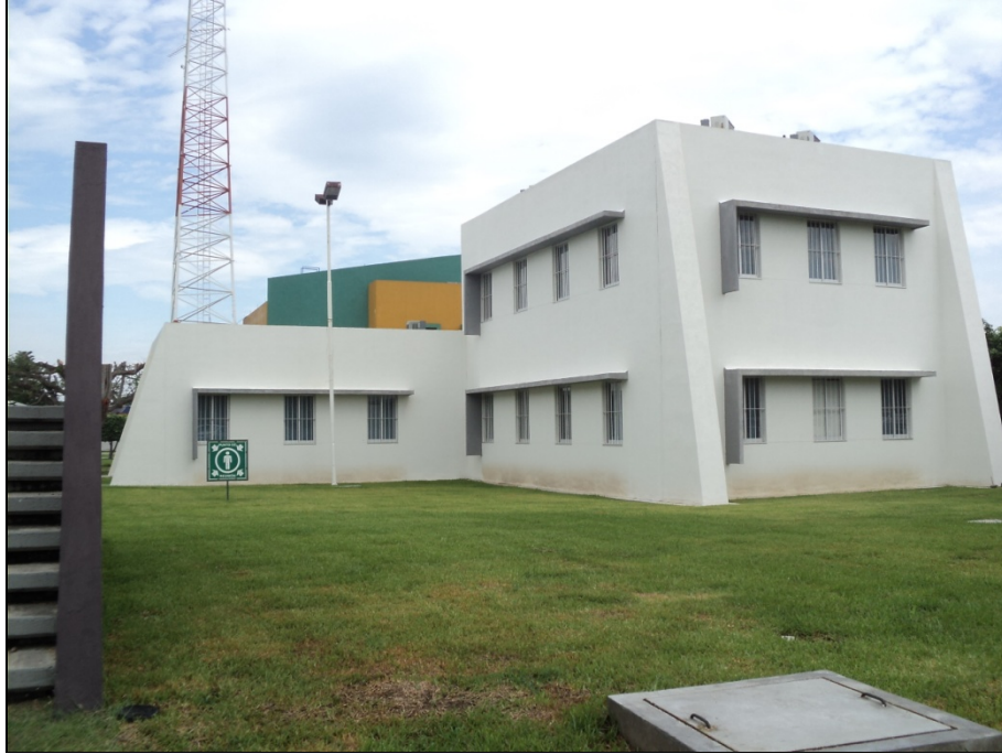
Construcción de Cubículos.- Facultad de Telemática
