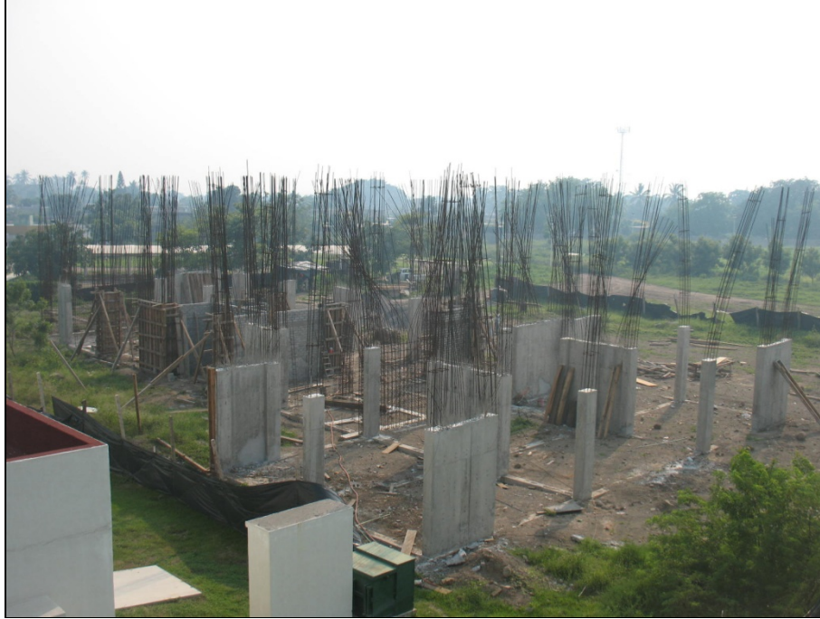
Construcción del Lab. de Ingeniería Química.- Facultad de Ciencias Químicas
