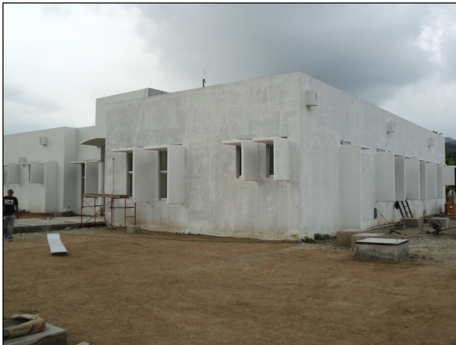
Construcción de 3ª. Etapa de Gastronomía.- Escuela de Comercio Exterior
