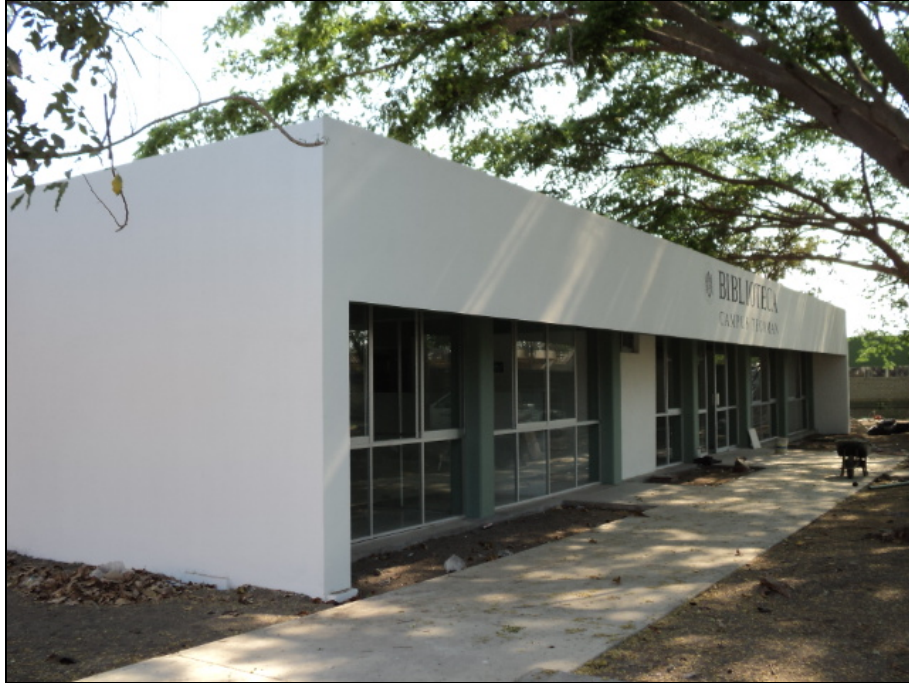
Ampliación y Adecuación de Biblioteca de Ciencias Agropecuarias Tecomán
