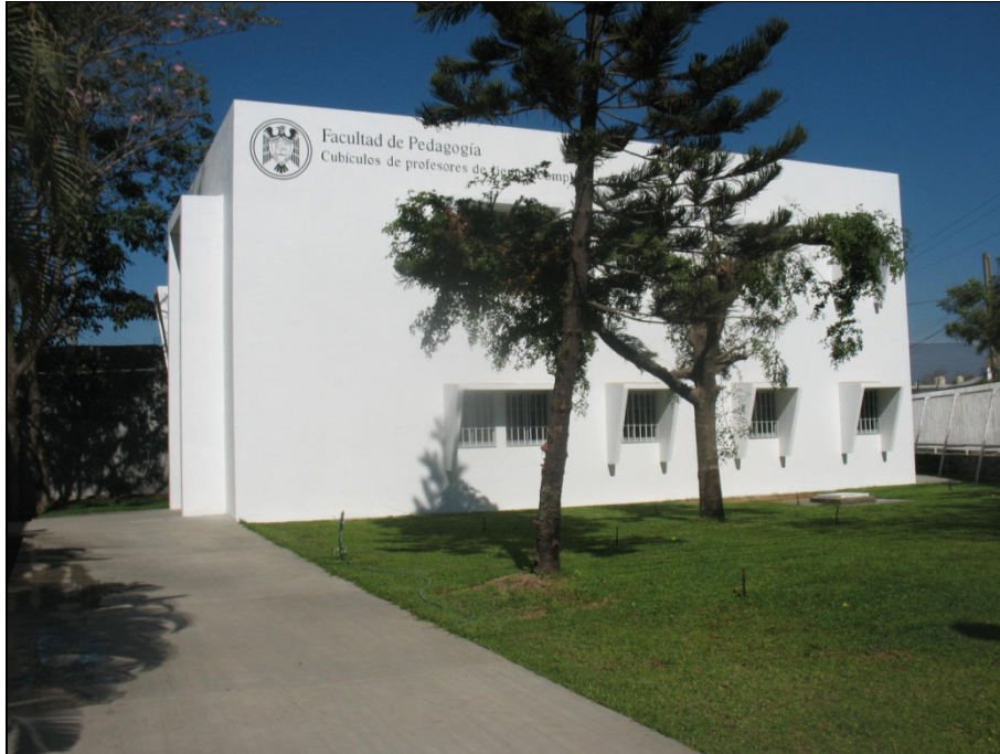
Construcción de Cubículos para P.T.C.- Facultad de Pedagogía
