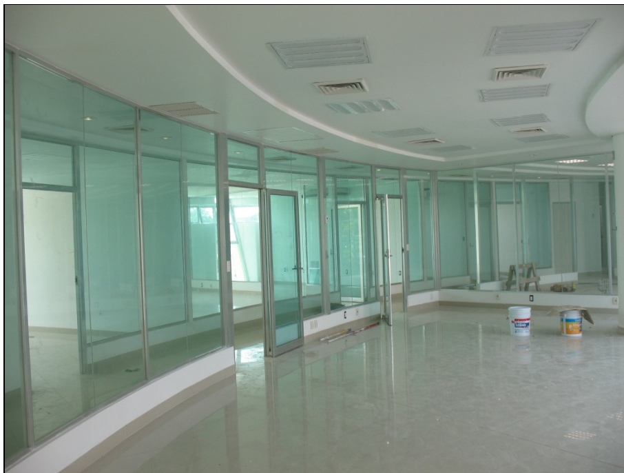
2ª Etapa Construcción de Edificio Administrativo y Financiero.-Institucional
