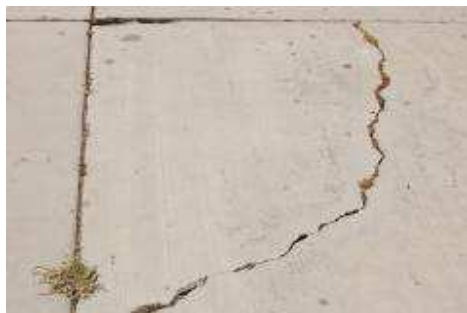
GRIETAS EN LAS LOZAS DEL PATIO CIVICO
