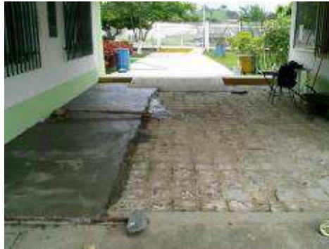
Preparación del espacio para cambio de piso y construcción de rampa.
