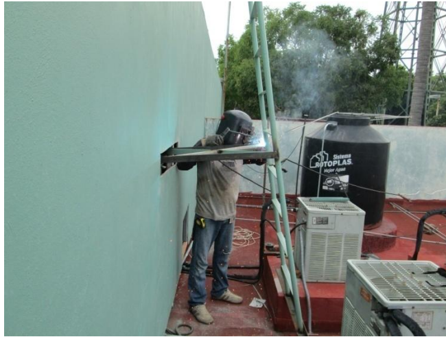
Fabricación y montaje de escalera marinera
