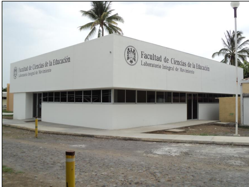
Construcción del Laboratorio Integral de Movimiento. - Facultad de Ciencias de la Educación, Delegación 3, Campus Central, Colima, Col.
