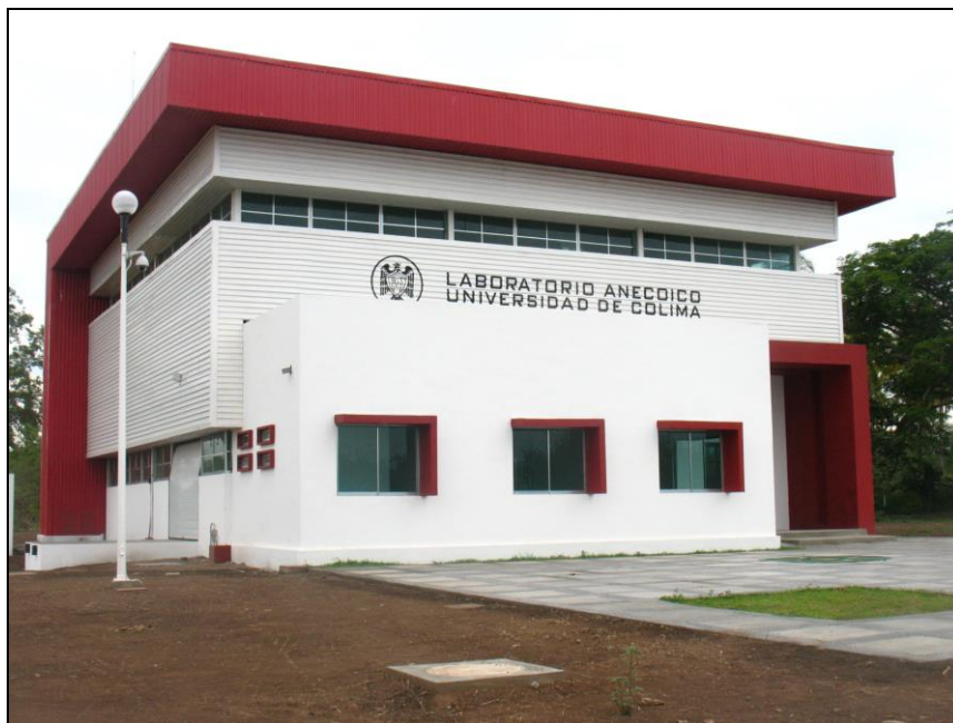
Construcción de Laboratorio Anecoico de Radio Frecuencia.-, Tecno-Parque, Colima, Col.
