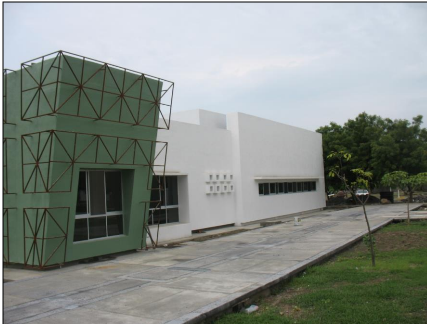
Construcción de Laboratorio de Alimentos y Bebidas.-, Fac. de Turismo, Delegación 5, Campus Villa de Álvarez, Col.
