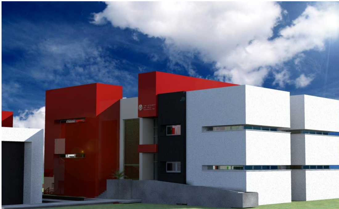
Construcción de la 1ª. etapa de la Unidad de Investigación para el Instituto de Ciencias de la Vida.- C.U.I.B., Colima, Col.
