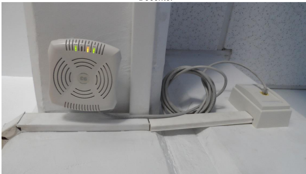
Imagen 1.32. Wireless Access Point Aruba 93 instalado en la planta alta de la Unidad de Formación Docente.
