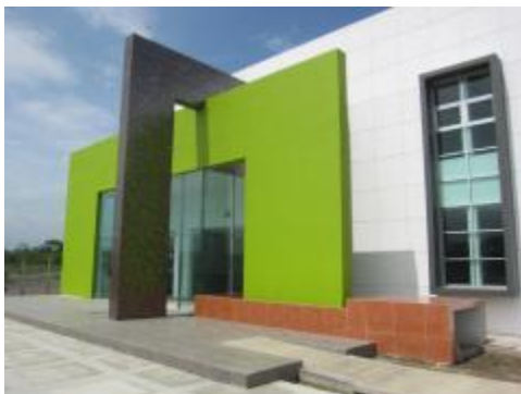
Infraestructura generada con recursos de FOMIX Colima y de la Universidad de Colima
