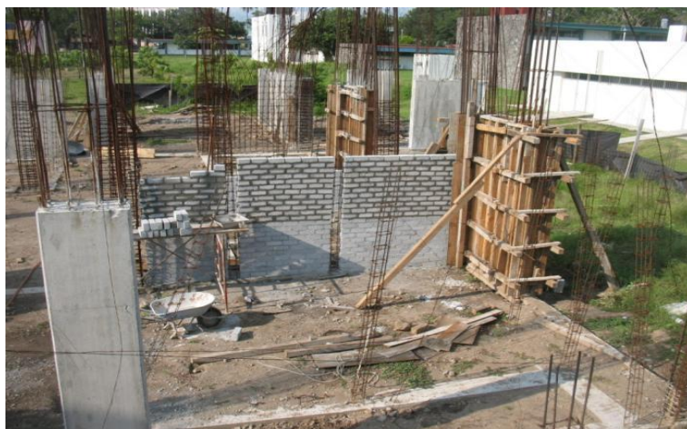
Construcción del Laboratorio de Ingeniería Química.
