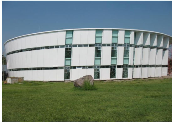
Segunda etapa construcción del Edificio Administrativo y Financiero. Fuente: Informe de labores 2011. Dirección General de Obras Materiales.
