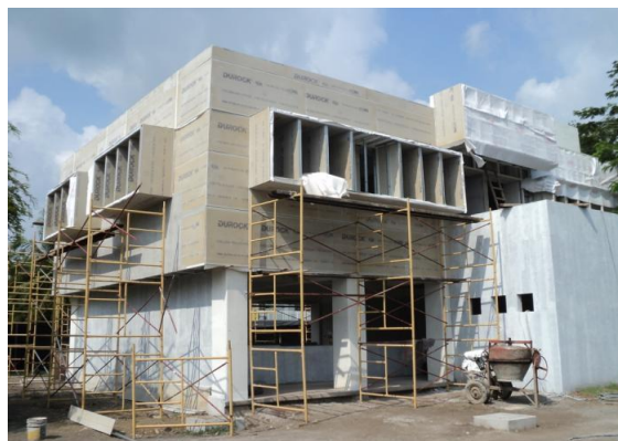
Construcción del Módulo de Aulas y Sanitarios de FCBA. Fuente: Informe de labores 2011. Dirección General de Obras Materiales.
