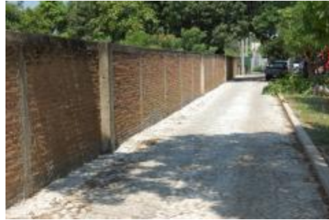
Remodelación del acceso al estacionamiento del plantel
