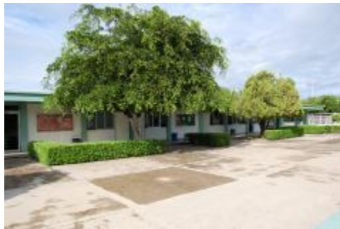
FACHADA DEL PLANTEL VISTA DESDE EL INTERIOR
