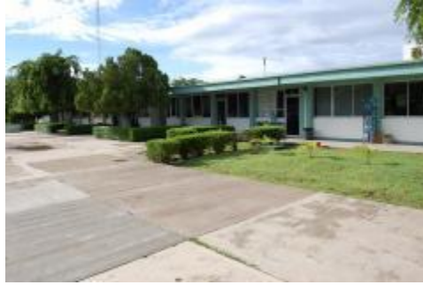
FACHADA DEL PLANTEL POR EL ACCESO AL MISMO
