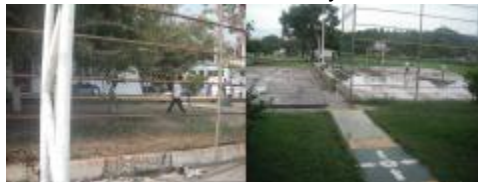
Foto Cancha Usos Múltiples Mantenimiento de Malla Ciclónica y Estructura
