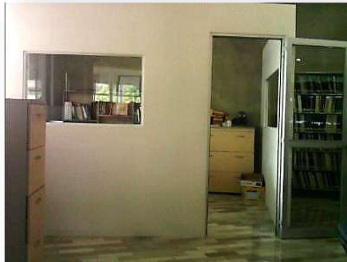
Imagen 7. Construcción de cubículo dirección y área de recuperación
